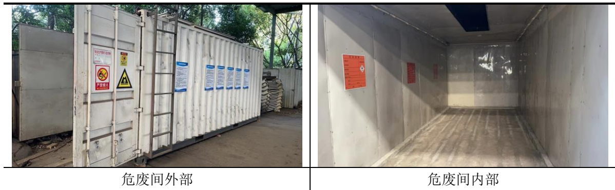
图 4-3 危废贮存场所照片
